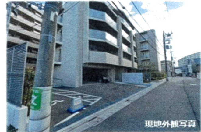
現地外観写真
